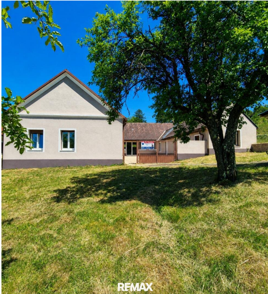
Haus mit Innenhof
