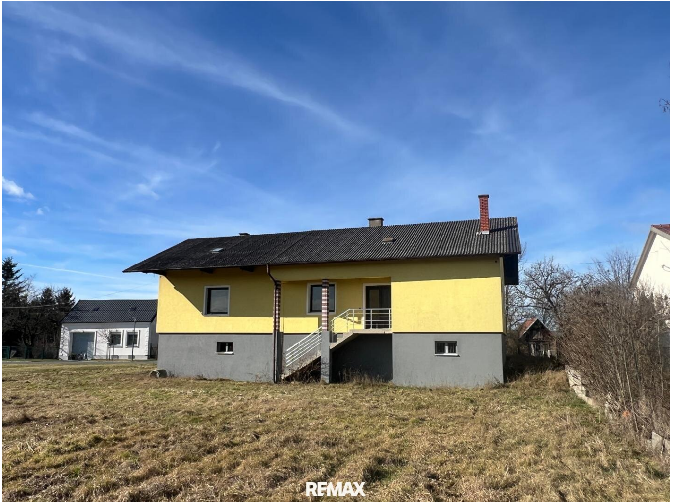
Ansicht vom Grundstück
