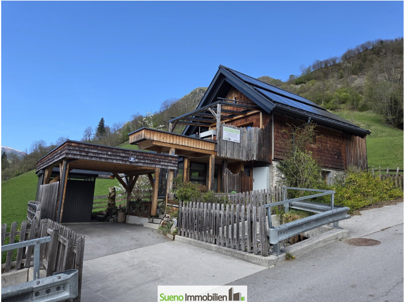
Hausansicht von Süden
