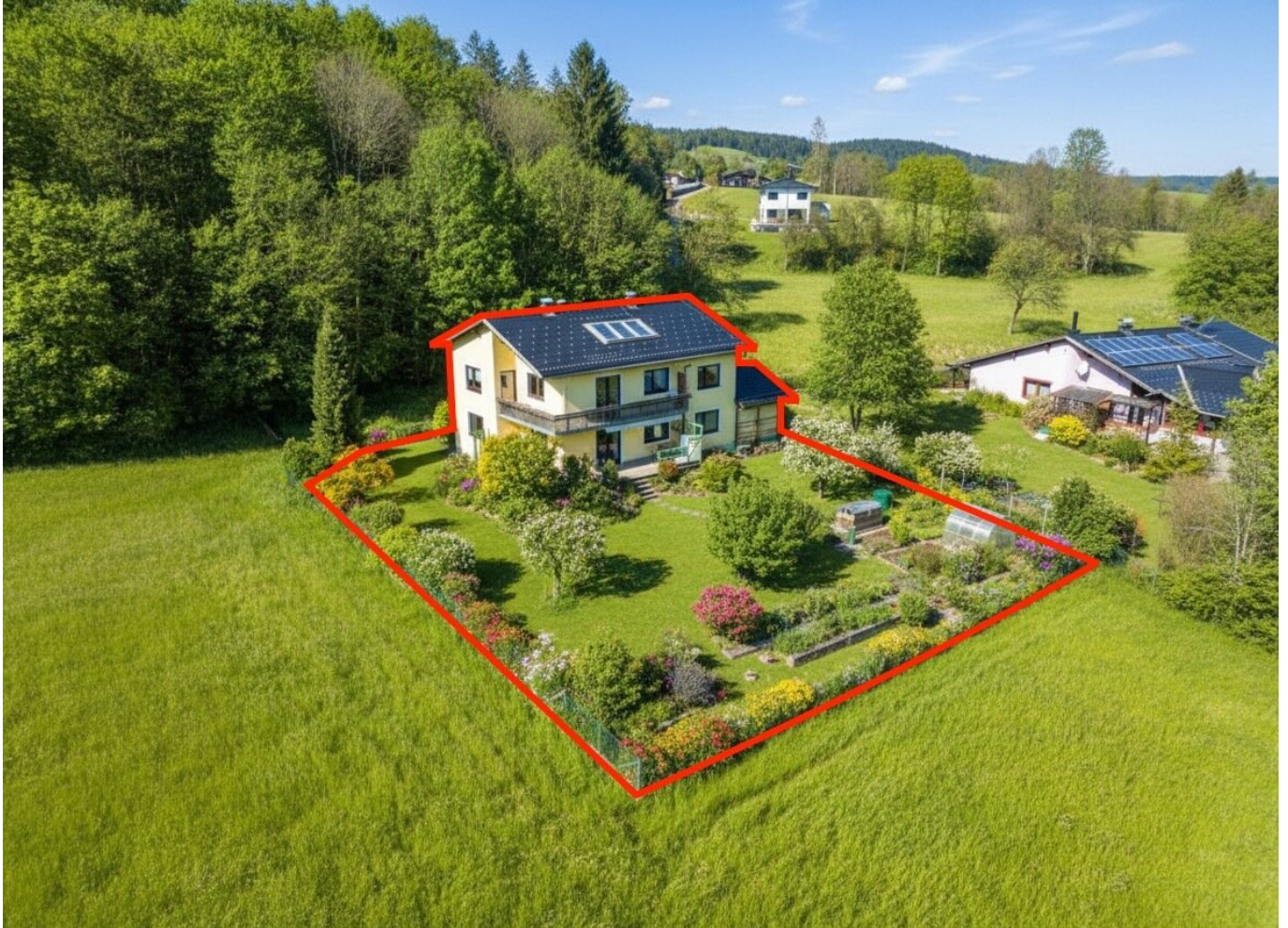
Luftbild Haus mit eingezeichnetem Grundstück
