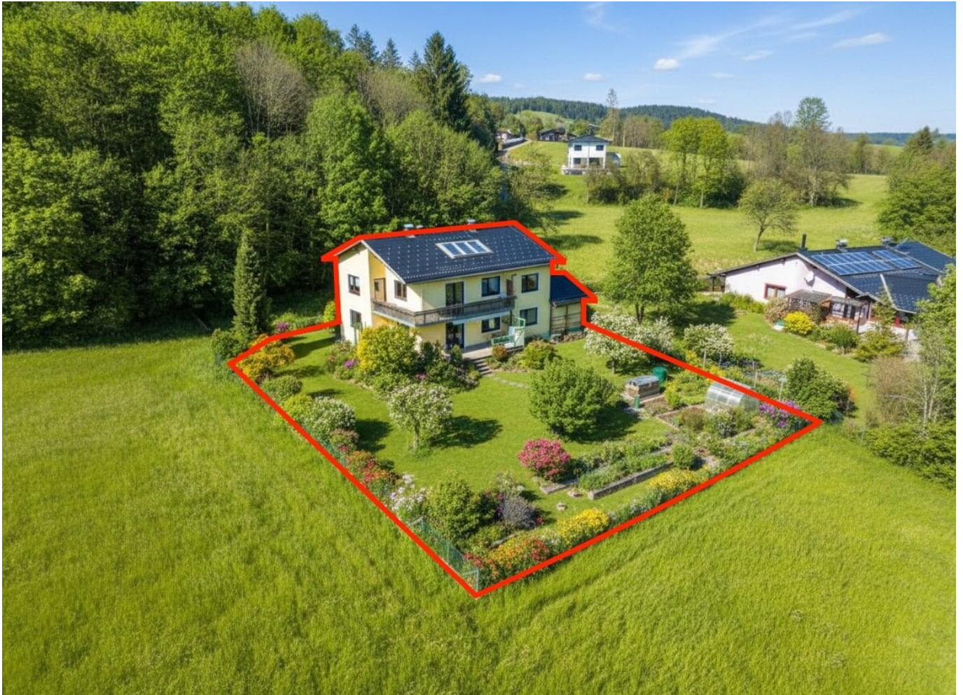
Luftbild Haus mit eingezeichnetem Grundstück
