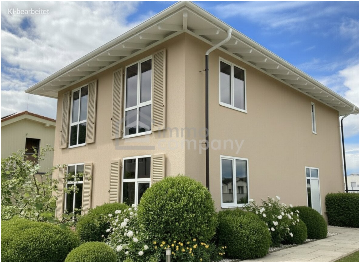
Ansicht außen Straßenseite
