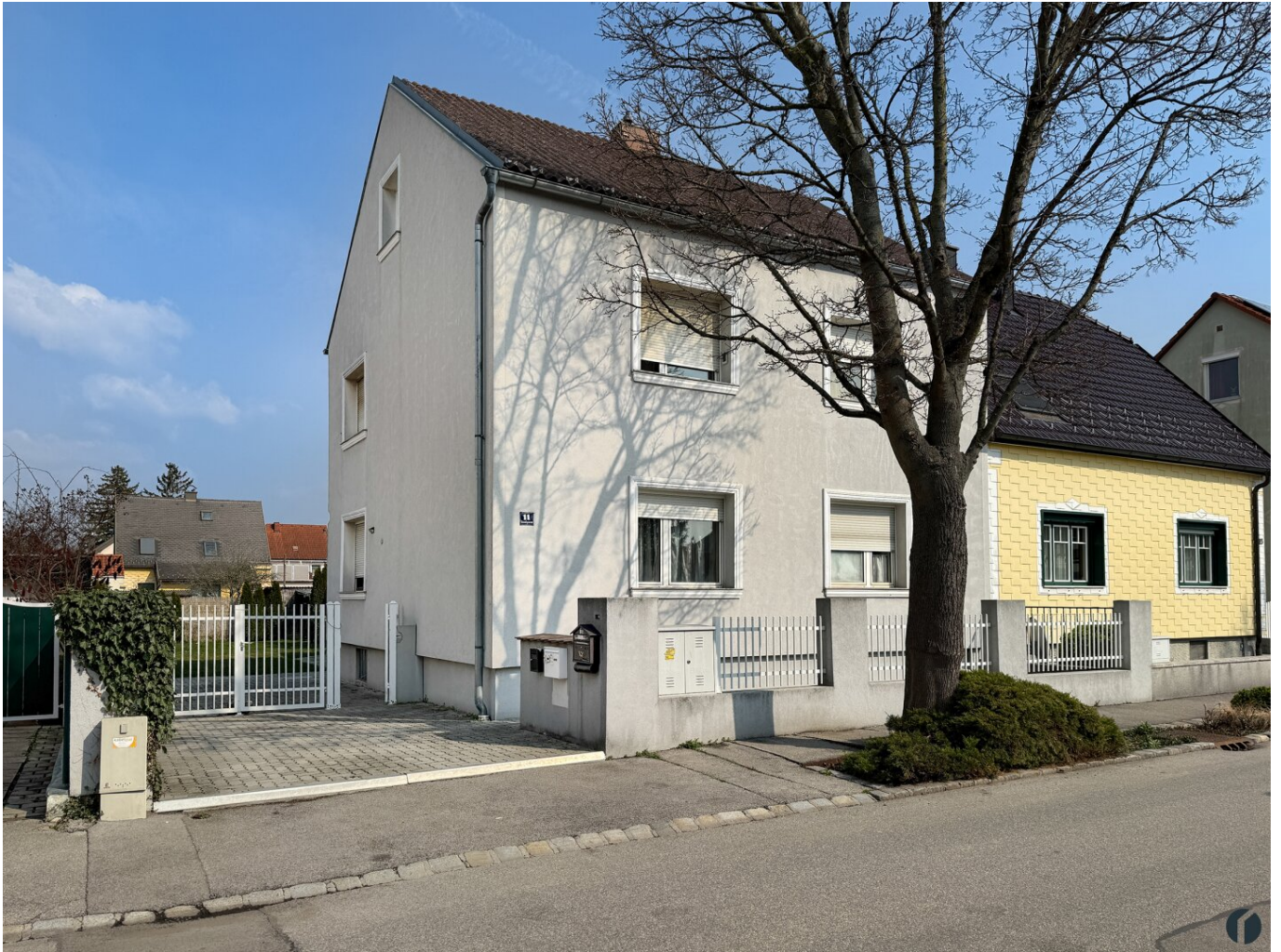
Außenansicht von der Straße aus
