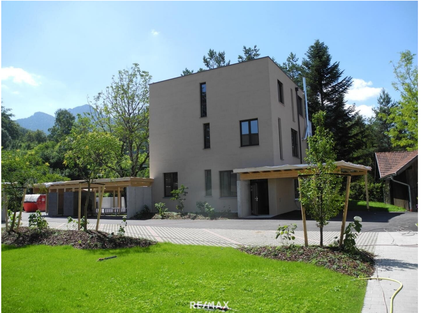
Gebäude mit Kellerzugang - Türe rechts EG
