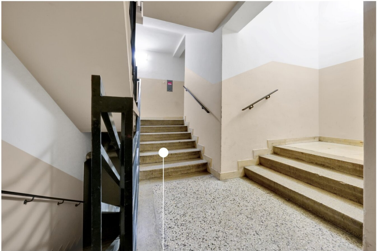
Stufen vor dem Lift im EG
