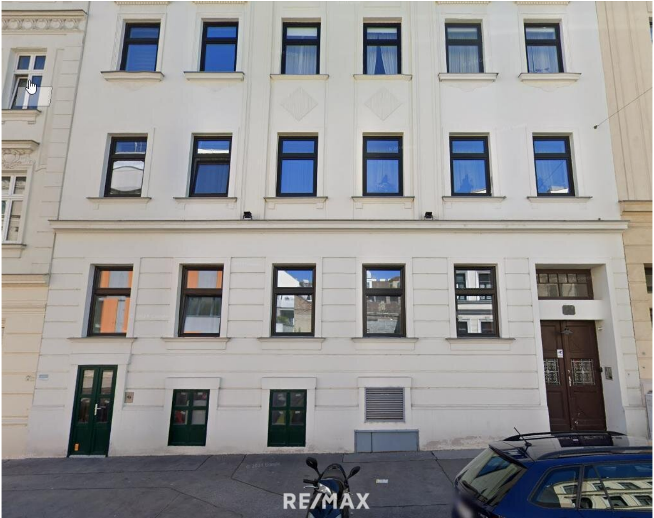
Gebäude von Aussen
