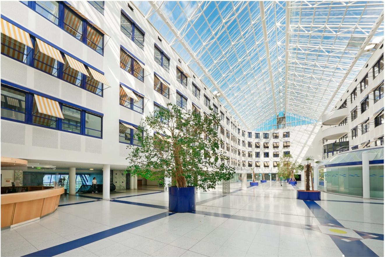
Glas Atrium "Plaza" mit Portierloge (links im Bild)
