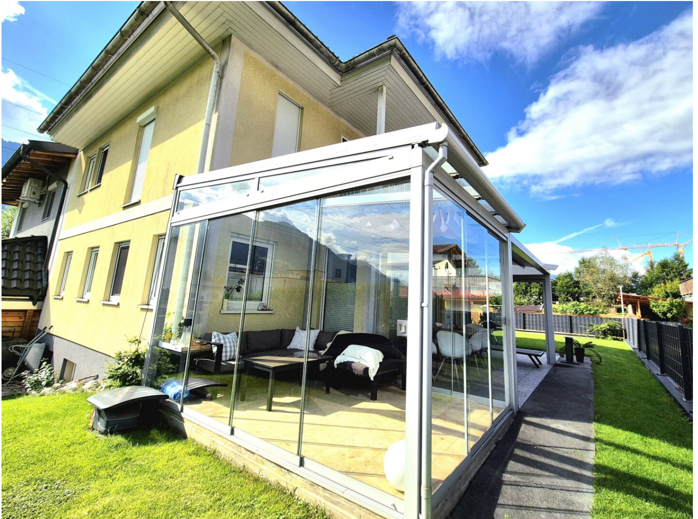
Außenfassade mit Wintergarten
