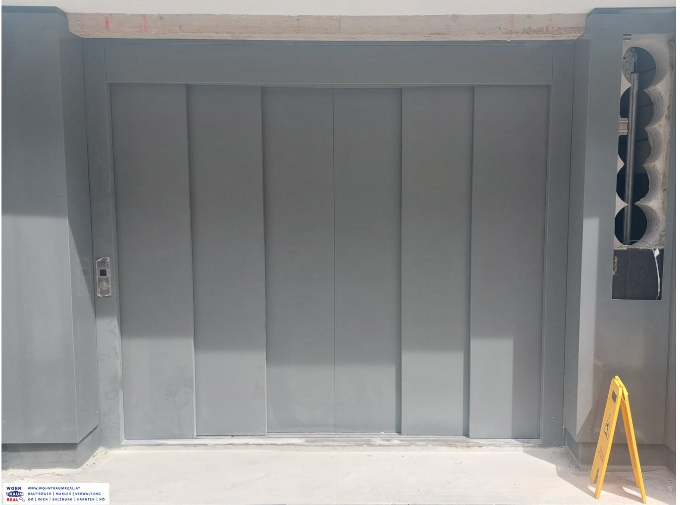
Tiefgarage mit Lift
