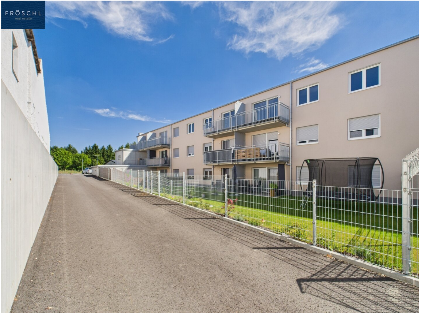
Ansicht der Gartenwohnungen - Pic 1
