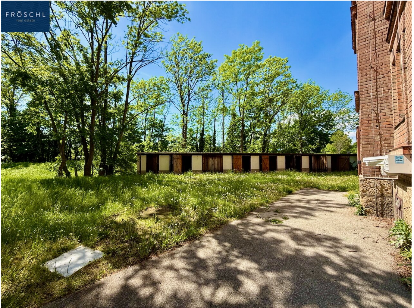
Ansicht Gartenseite - Objekt Werksgasse 8
