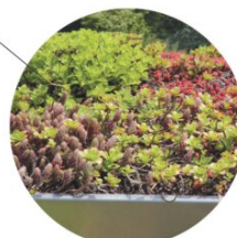
Begrünte Carport Dächer
