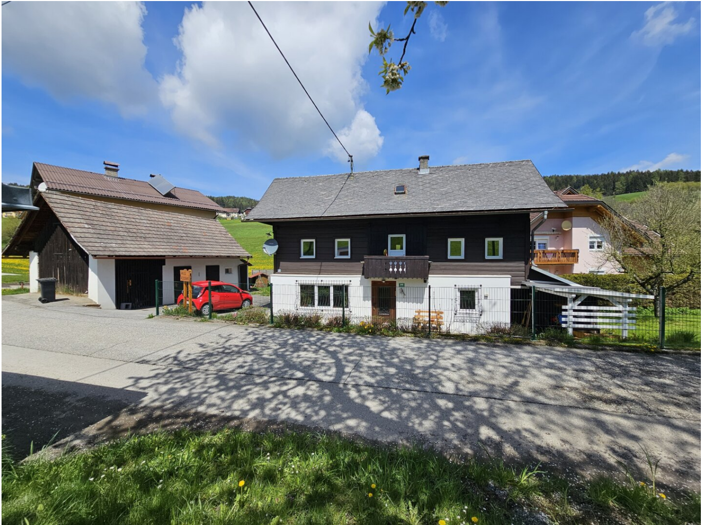
Haupthaus mit Wirtschaftsgebäude
