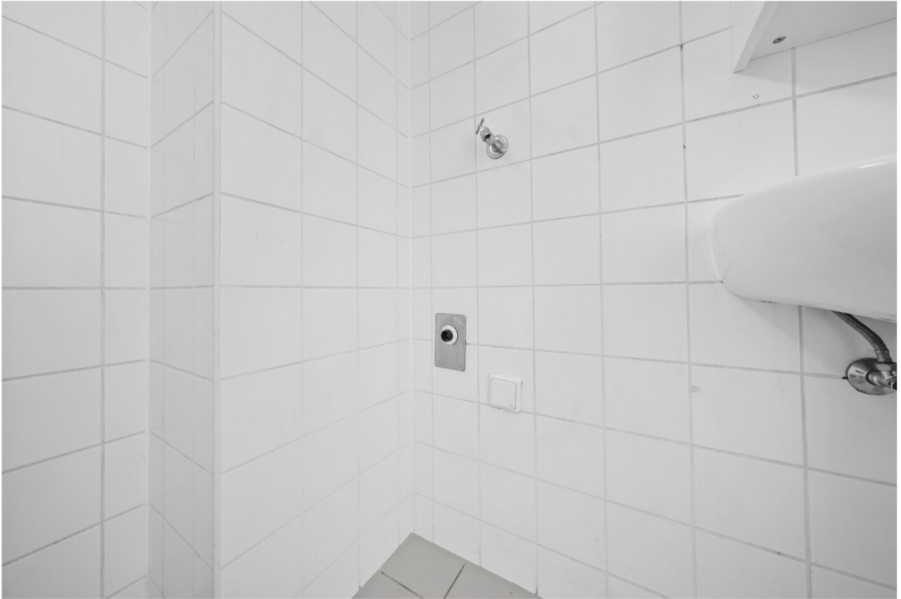
Waschmaschinenanschluss
