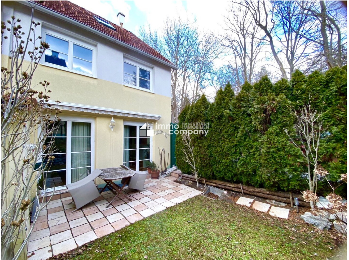
Haus mit südseitigem Garten
