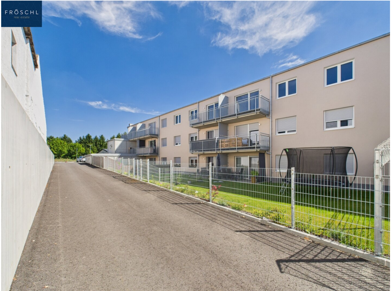
Ansicht der Gartenwohnungen - Pic 1
