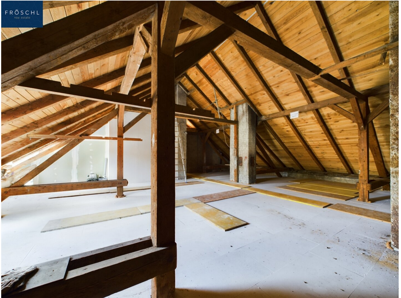
Ansicht Rohdachboden - Pic 1
