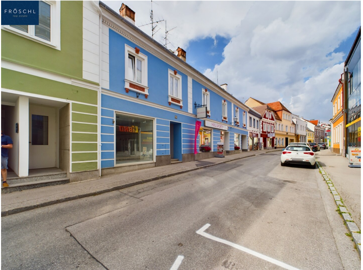
Hausansicht und Eingang Top 7
